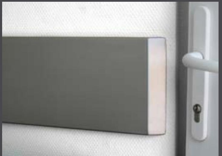
Mit Rammschutzprofilen werden Wände vor Beschädigungen im rauen Betriebsalltag geschützt.
