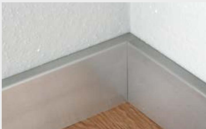
Für Innenecken liegen keine Formstücke vor. Diese sind im Zuge der Montage wahlweise „Stumpf gestoßen“ oder mit „Gehrungsschnitt“ zu montieren.
