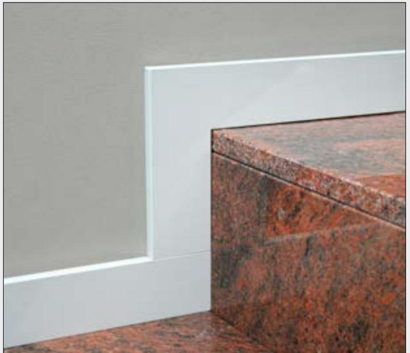
Für Treppen ohne Untertritt können ALU-PLAN® Sockelleisten der Serie G auch Stufenwinkel angefertigt werden. Hierdurch wird die Sockelleiste optisch zwischen den Etagen fortgesetzt. Schlitzze zur aufgehenden Wand werden wie bei der klassischen Montage – als Sockelleiste – verdeckt.
